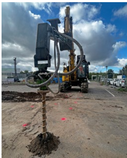
Kampfmittel- sondierung September 2025 Foto: CCS GmbH
