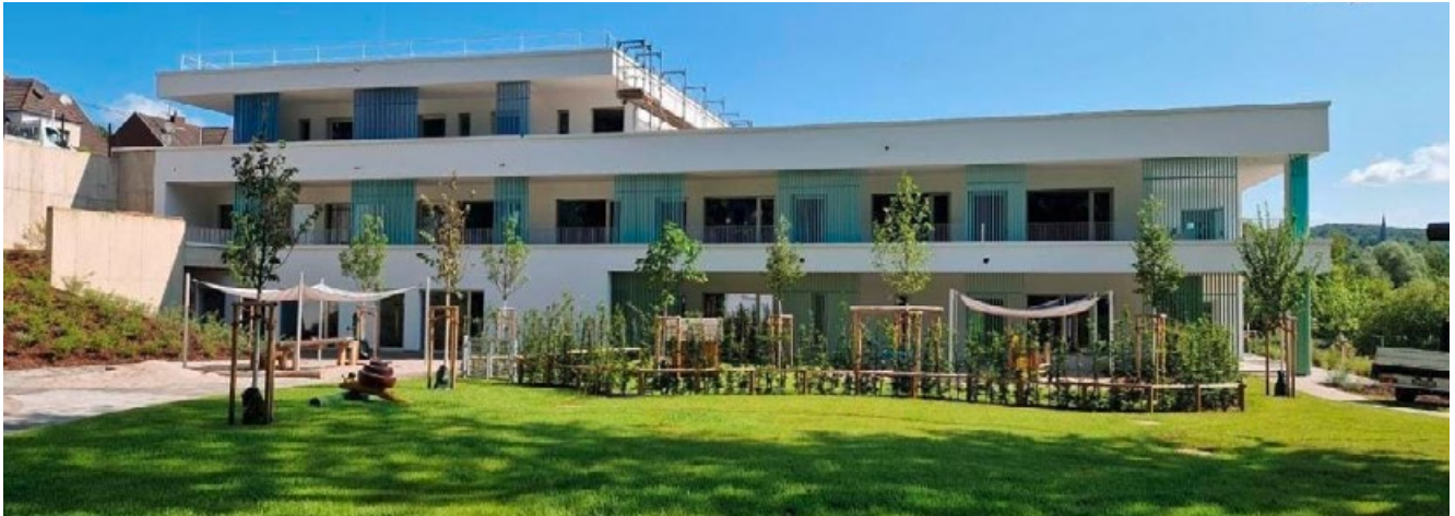
Mehrgeschossiger Massivbau, im Norden drei-, im Süden zweigeschossig (GMS)
