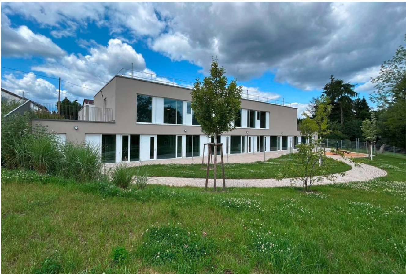
Südansicht Kita Waldwiese: zweigeschossiger Massivbau (GMS)
