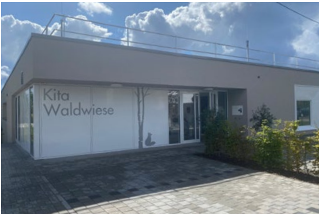
Nordansicht Kita Waldwiese: Eingangsbereich (GMS)
