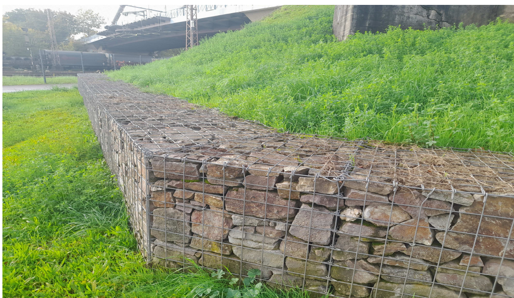
Abb. 4: Gabione mit Hinterfüllung (Erdmaterial)
