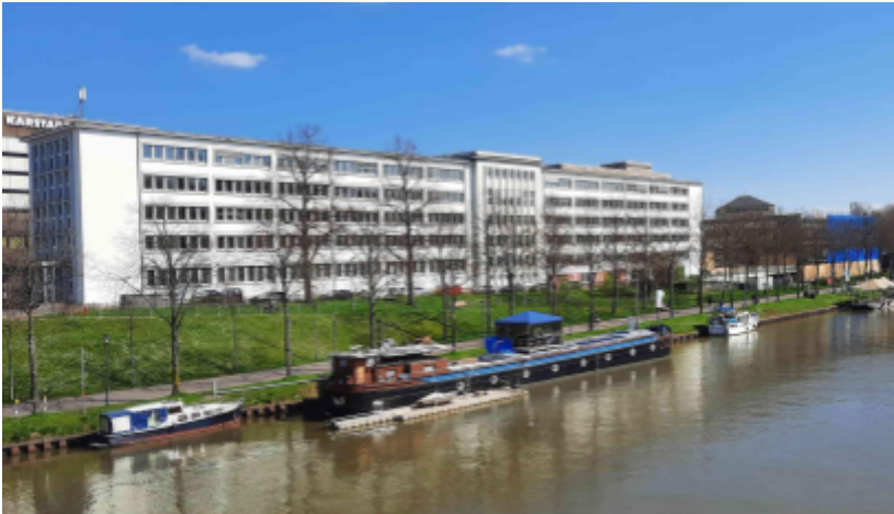
Abbildung 01: Das ehemalige Finanzamt am Stadtgraben, Baujahr 1952, Architekten Friedrich Karl Rheinstädter und Walter Wundrack (Foto: Landesdenkmalamt des Saarlandes)
