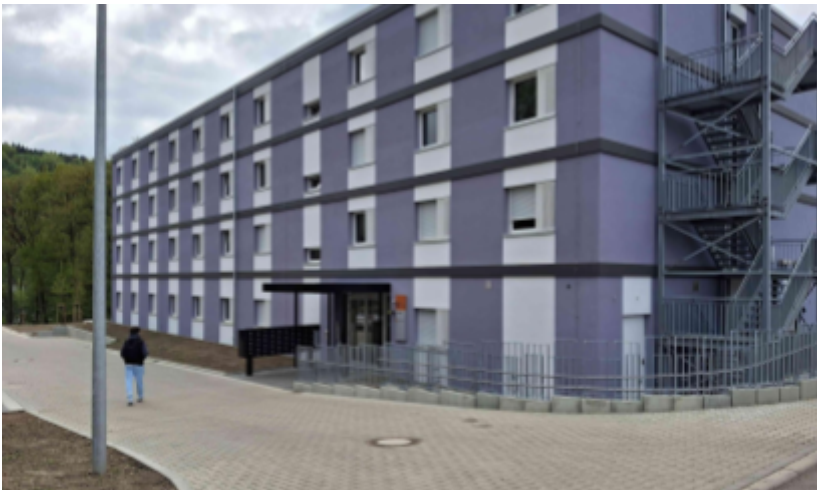
Abbildung 16: Neu erbaute Wohnheime in Modulbauweise nach dem System Goldbeck (Foto: P. Dörrenbächer)
