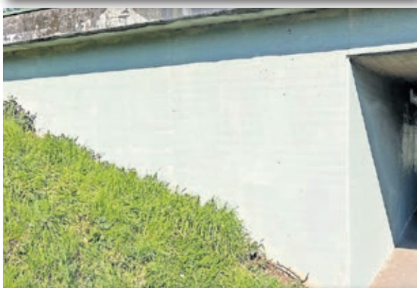
Die Brücke in St. Arnual nach der Reinigung im Rahmen der Aktion „Saarland Picobello“.
