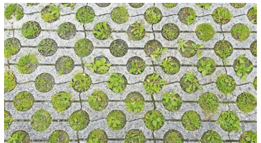
Rasengittersteine tragen dazu bei, dass Entsiegelung reduziert wird und Regenwasser besser versickern kann. Foto: FotoSabine - stock.adobe.com
