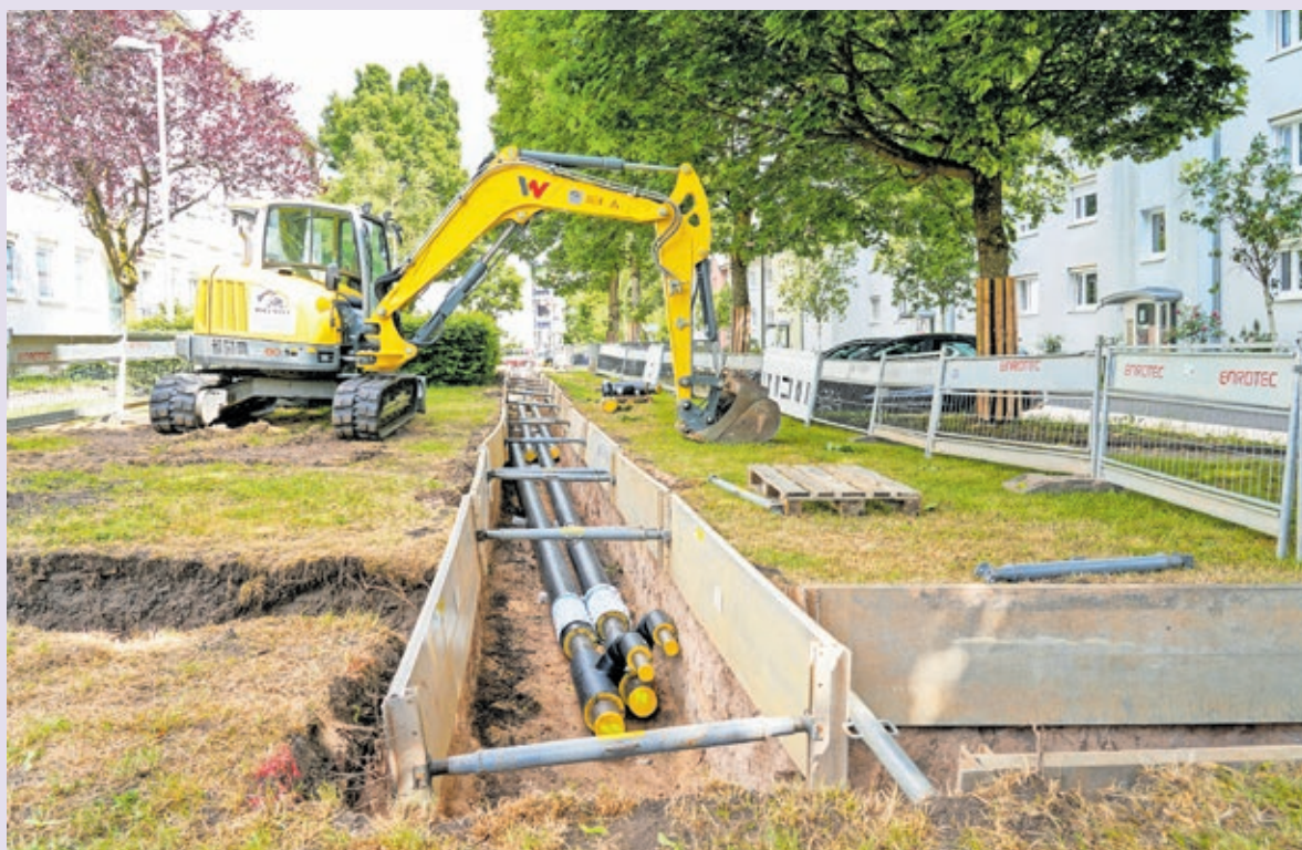
Fernwärmeausbau in der Moltkestraße und im Richtweg in Alt-Saarbrücken.
