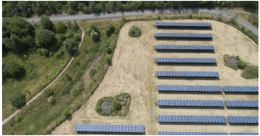
Drohnenaufnahme Referenzprojekt „Solarpark Brönchestal“; Quelle: RAG Montan Immobilien GmbH, Im Welterbe 1-8, 45141 Essen
