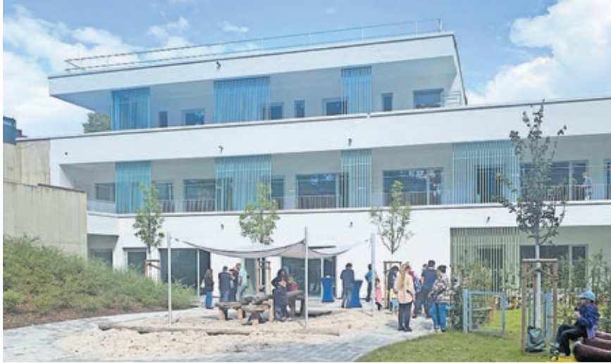
Außenansicht der Kita Saarbrücken-Dudweiler Lindengarten.
