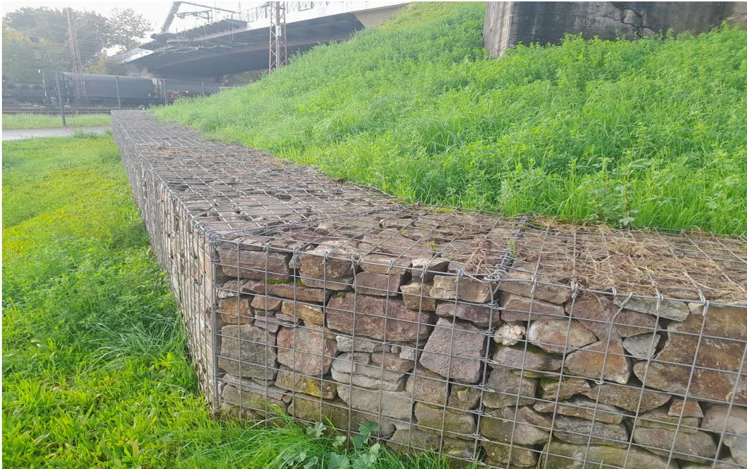
**Abb. 5: Gabione mit Hinterfüllung (Erdmaterial)**
