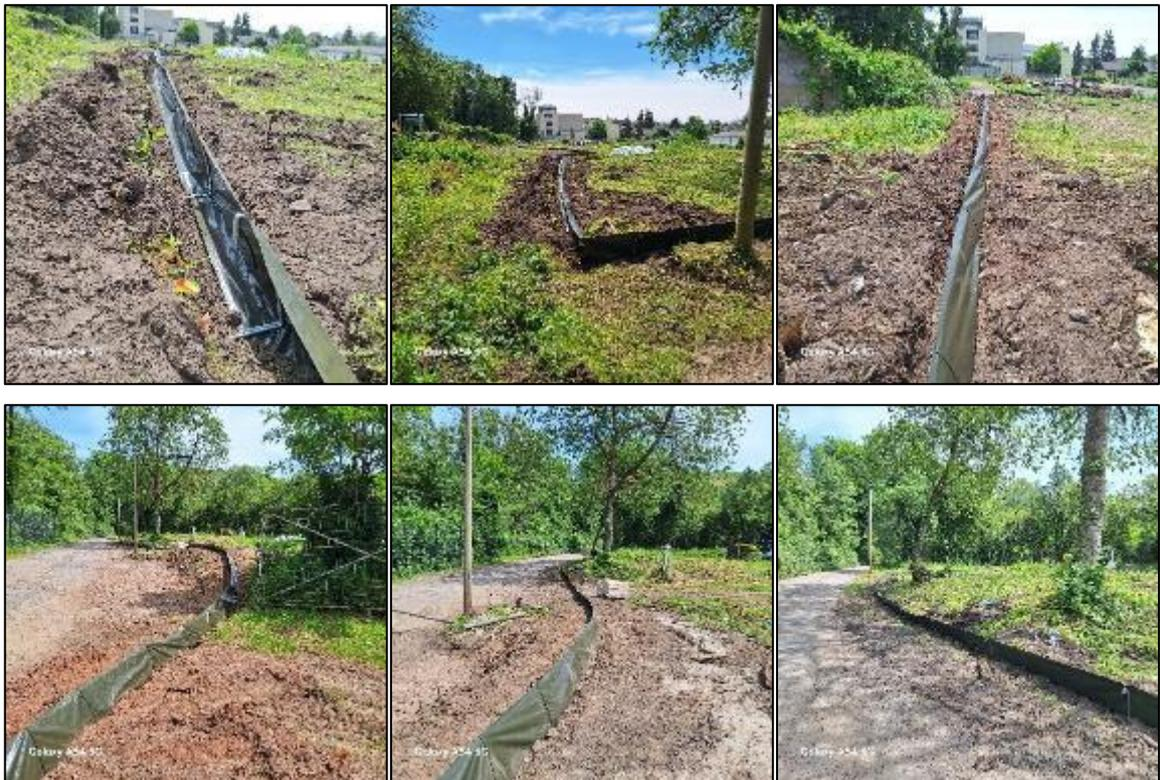
Abb. 2 a-f: Herstellung des Reptilienschutzzauns im Bereich des 2. BA
