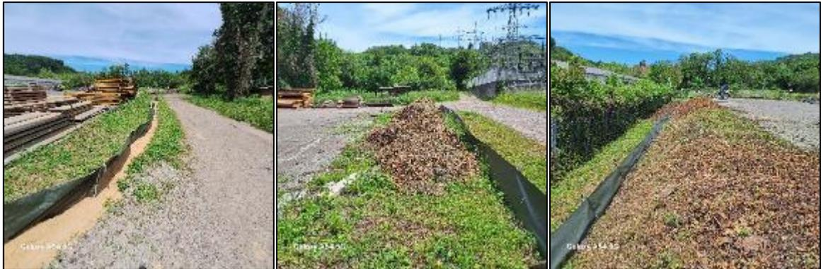
Abb. 1 a-c: Reptilienschutzzaun 1. BA nach Instandsetzung nach dem Starkregen im Mai 2024
