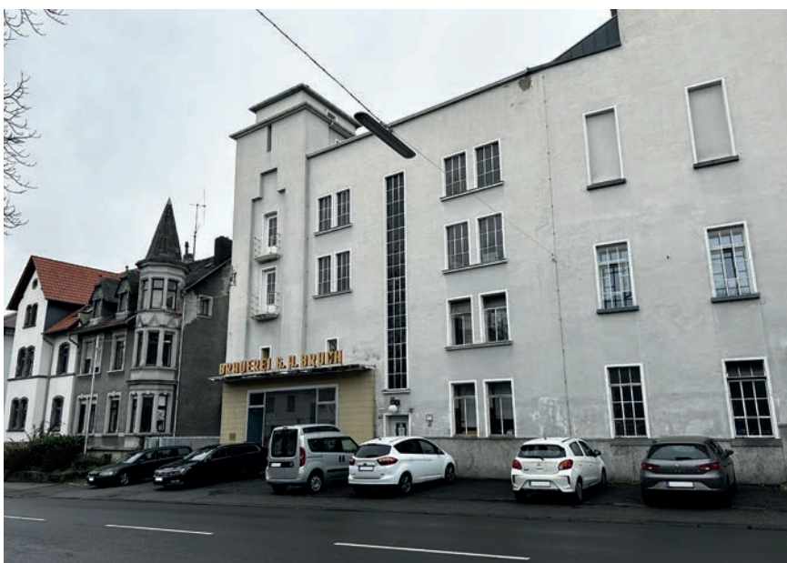
Blick auf das Bestandsgebäude der ehem. Bruch-Brauerei sowie der westlich angrenzenden Bebauung
