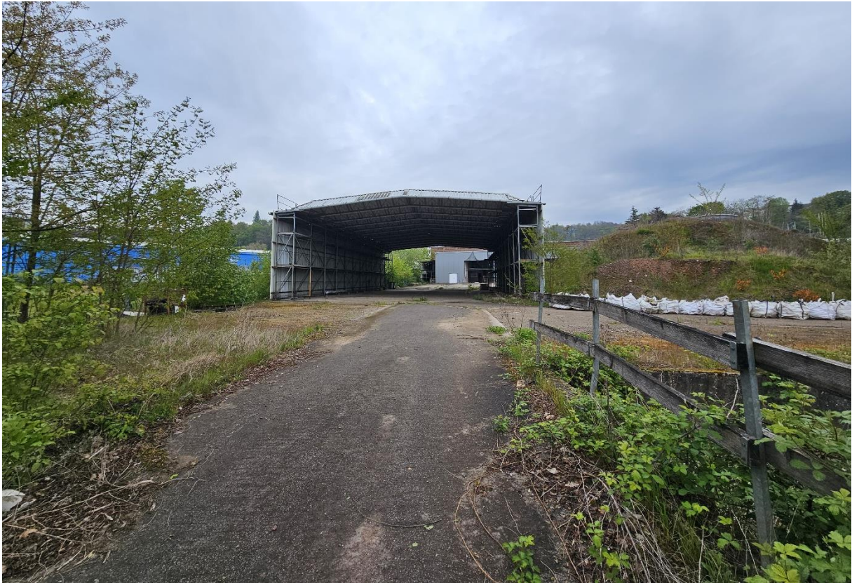
Abbildung 7: Offene Lagerhalle im westlichen Teil des Untersuchungsgebiets
