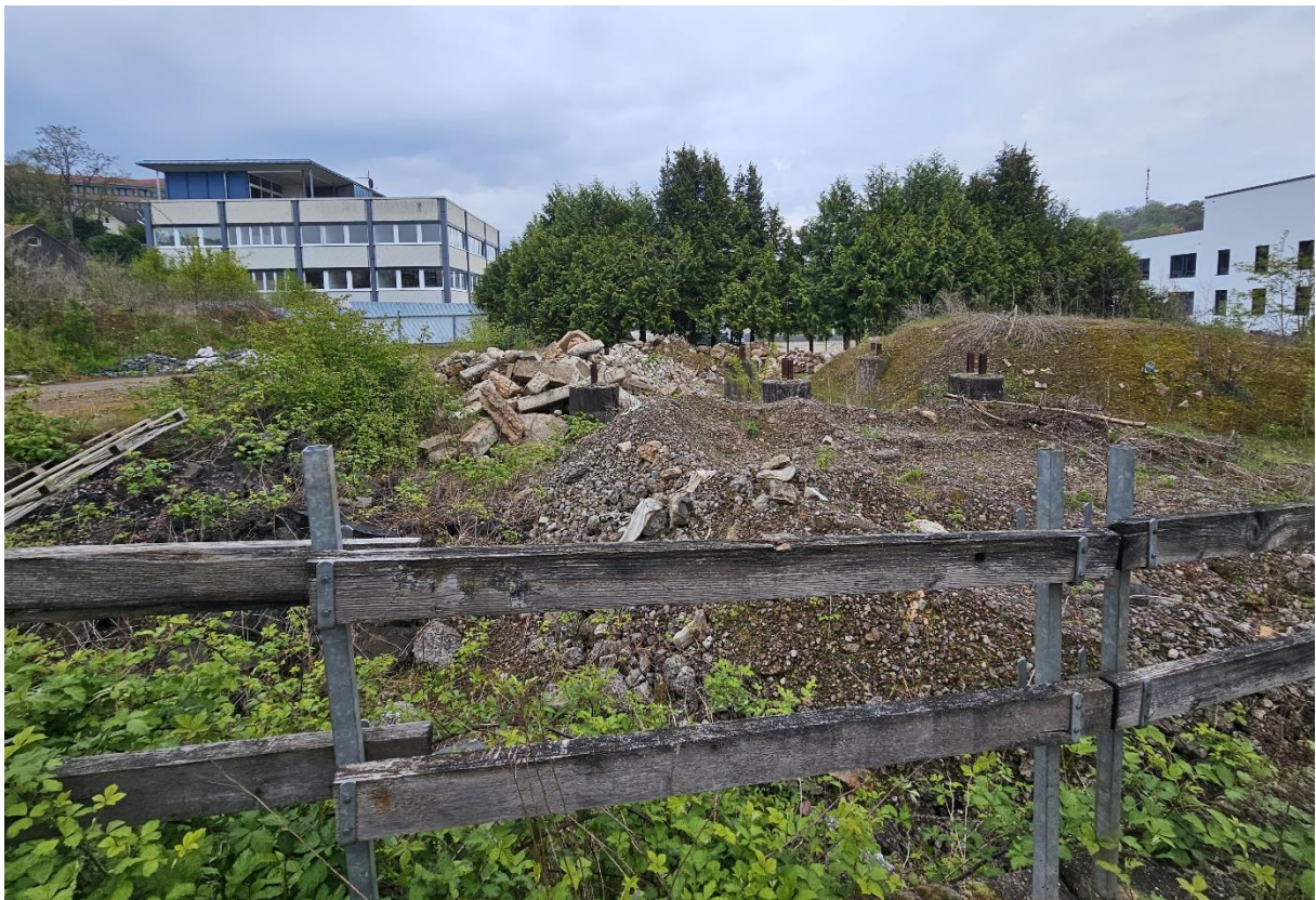
Abbildung 6: Schuttablagerungen im westlichen Teil des Untersuchungsgebiets
