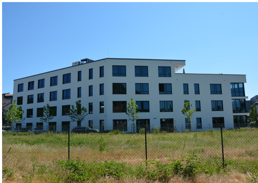
Blick auf das neu errichtete Gebäude westlich des Eschberger Wegs
