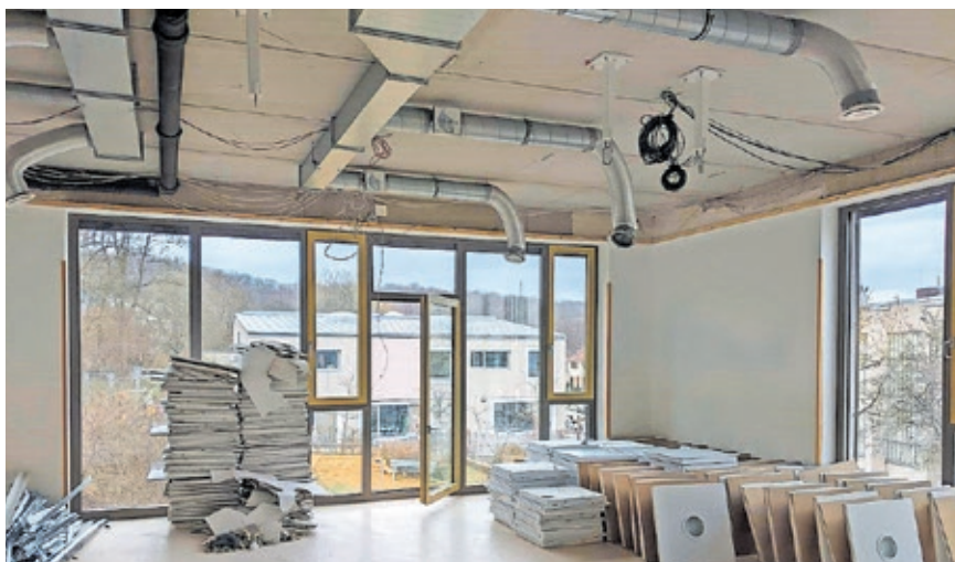
Die neuen Lüftungskanäle werden an der Decke im ersten Obergeschoss eingebaut und danach mit einer Abhangdecke verblendet. Foto: GMS
