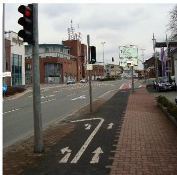
Abbildung 17: Radfahrschleuse am Knotenpunkt
