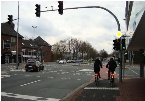
Abbildung 13: aufgeweitete Radaufstellstreifen
