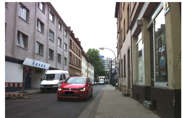
Situation vor Umbau
