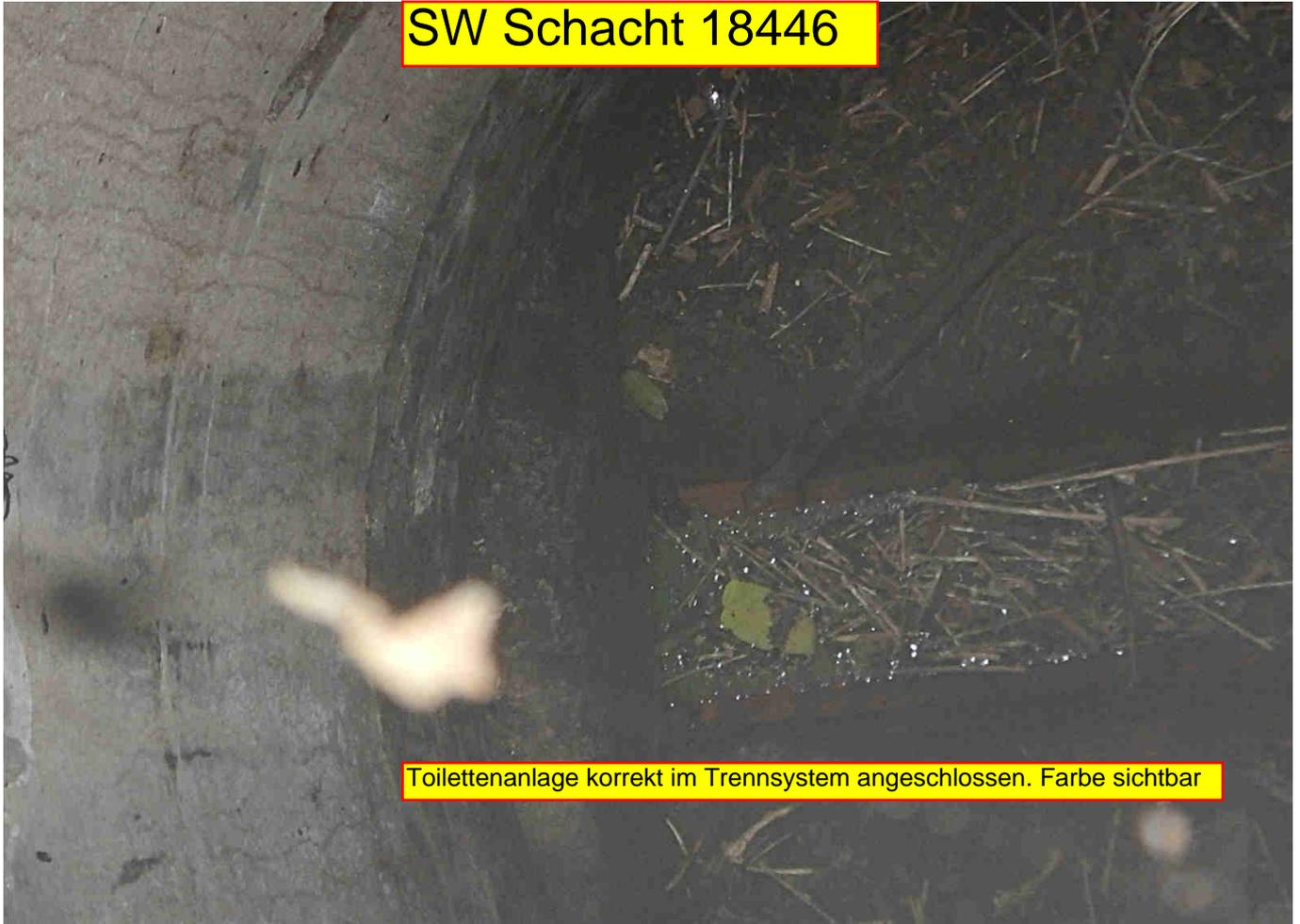
Toilettenanlage korrekt im Trennsystem angeschlossen. Farbe sichtbar
