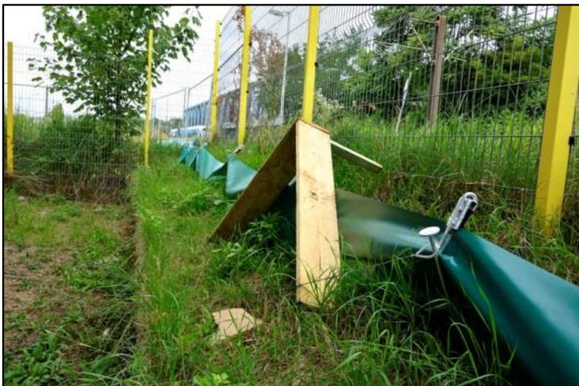
**Abb. 21:** Reptilienschutzzaun mit Übersteighilfe. Falls einzelne dismigrierende Individuen sich im inneren Bereich befinden, können diese nach Außen in die Kernbereiche zurückwandern.
